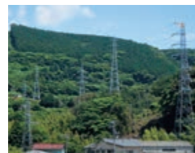
東京電力パワーグリッド(株) 稲取線鉄塔 (6.6万ボルト)
