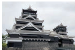
熊本城 (復旧整備)
