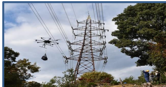
送電線がいし交換作業 ■使用機種：TK40
