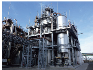
鹿島下水 2号焼却炉電気設備改築工事
