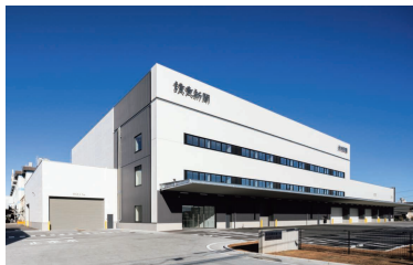
川越プロジェクト (印刷棟) 新築工事
