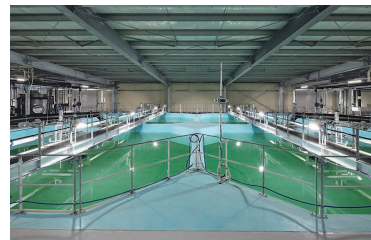
RKB陸上養殖新築工事
